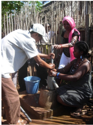
Photo n°1 : nettoyage de la pompe qui sent le pétrole.
