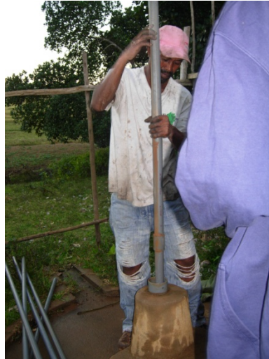
Photos n°2 et n°3 : Randria en train de démonter la pompe n°11 pour un nettoyage ; la pompe n°11 après la réparation.
